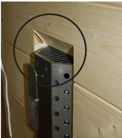
Afb. 1: Ventilatiesleuven vrij laten
