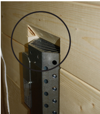
Kuva 1: Tuuletusraot vapaina
